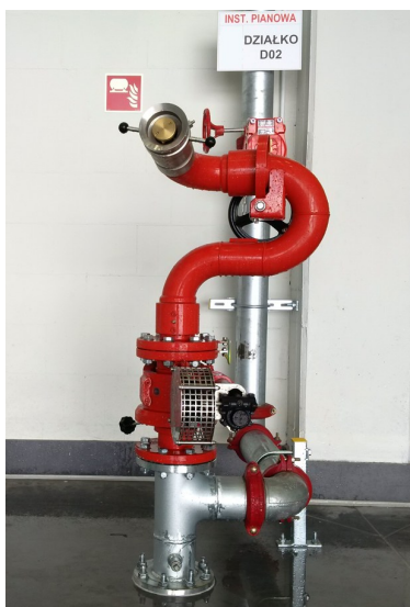
Rys. 2 Widok działka AKM zamontowanego na posadzce
